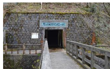
尾小屋鉱山メインロード入口
