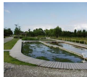
浄化ユニット③
