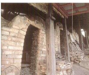
連房式登窯は、丘陵の傾斜面を階段状に整地し、焼成室を連続して構築した地上式の窯である。本窯の規模は、全長10.9m、幅2.9mで、上下二段に開口する焚口と5房の燃焼室、そして煙道からなっている。八幡における最後の登窯として、昭和40(1965)年頃まで使用されていたものである。近代九谷磁器窯の典型的形式を今に伝えており、昭和48(1973)年に小松市指定文化財となった。
